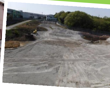
藤岡最終処分場
